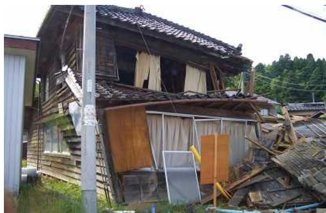
倒壊した家屋
